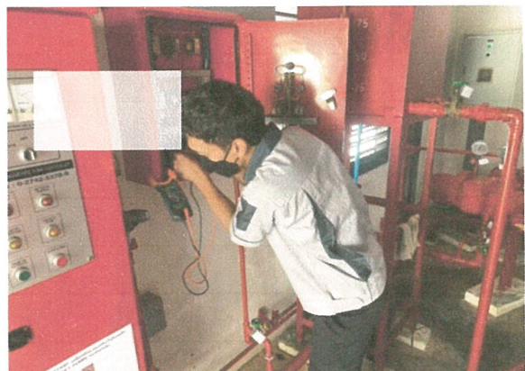
รูปภาพที่ 2.48 การตรวจสอบประสิทธิภาพของอุปกรณ์ป้องกันและแจ้งเตือนอัคคีภัย
